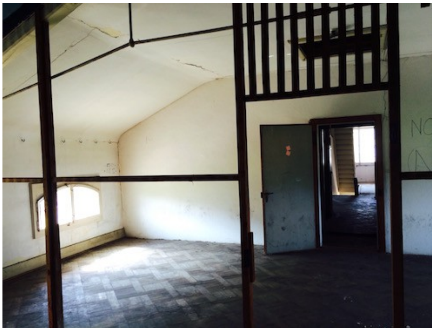
Der Dachstock. Die Oberlichter wurden zwischenzeitlich abgedichtet. (Bild Aldo Caviezel)
