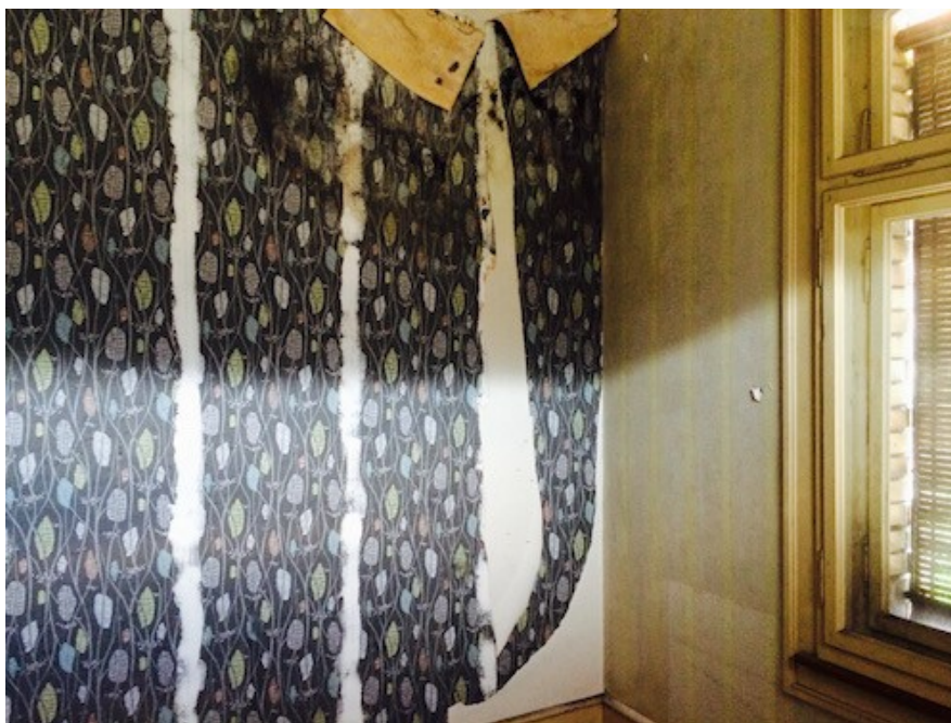
Tapete in einer Arbeiterwohnung. (Bild: Aldo Caviezel)
