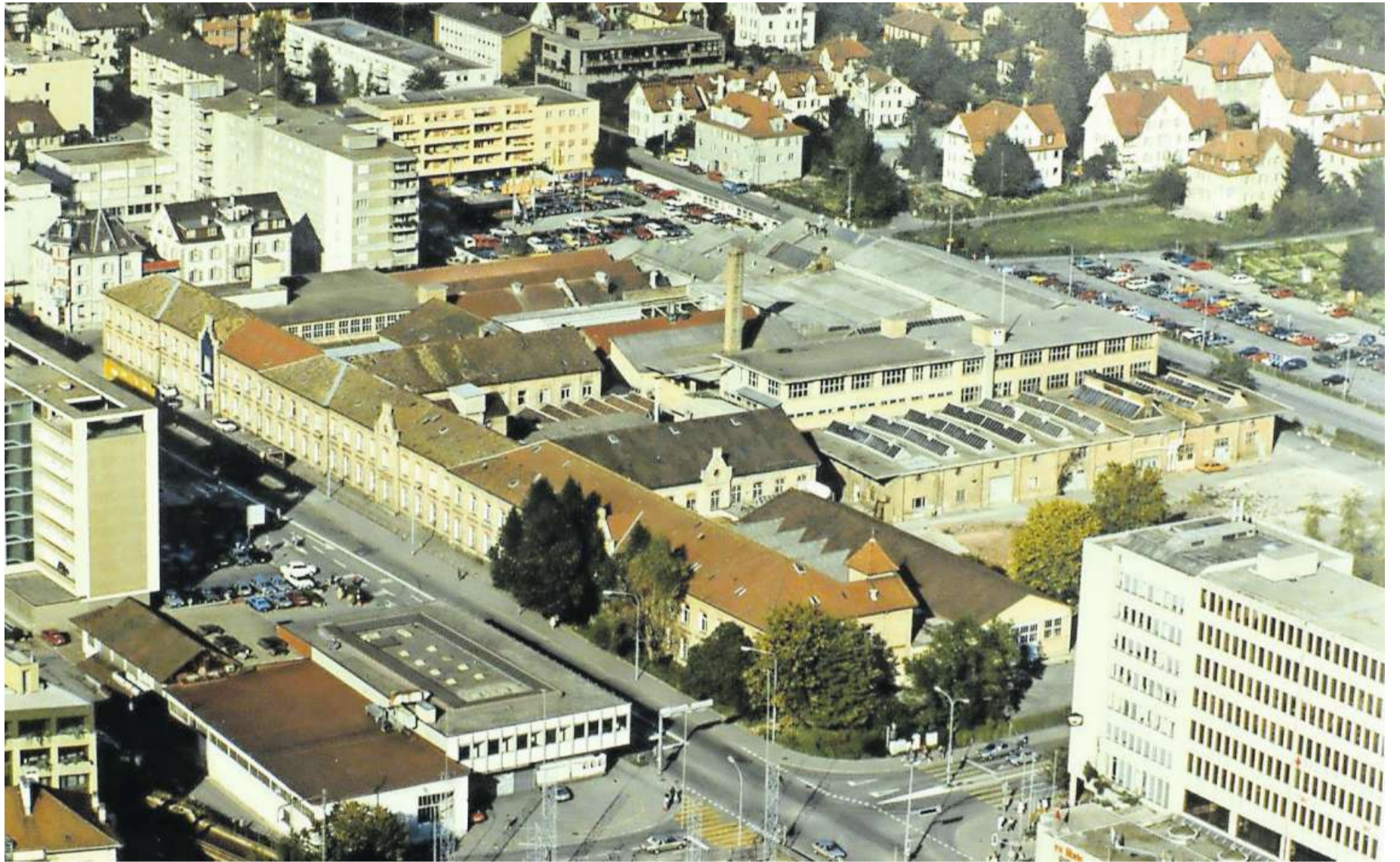
Die Metallwarenfabrik in Zug mit ihrer 168 Meter langen Sichtbacksteinfassade entlang der Baarerstrasse.
