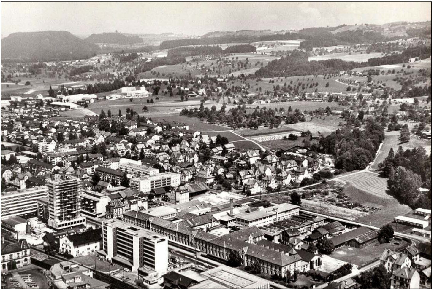
Flugaufnahme der Metallwarenfabrik und des Gebäudes von Etter Kirsch (rechts neben dem Bahnhofsgebäude) kurz vor dem Abbruch in den 1980er-Jahren.
